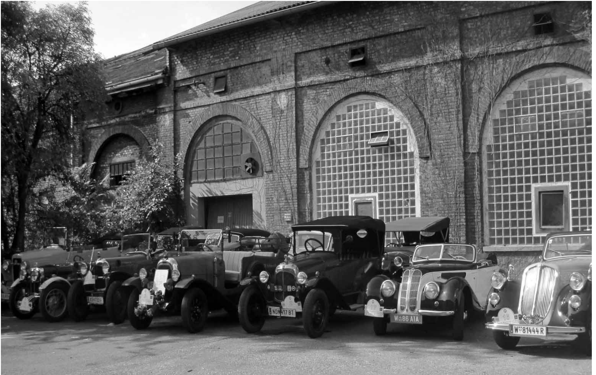
Preis des Bürgermeisters von Wien - Die Teilnehmerfahrzeuge vor historischen Bahnbauten nahe der Hauptbahnhofbaustelle
